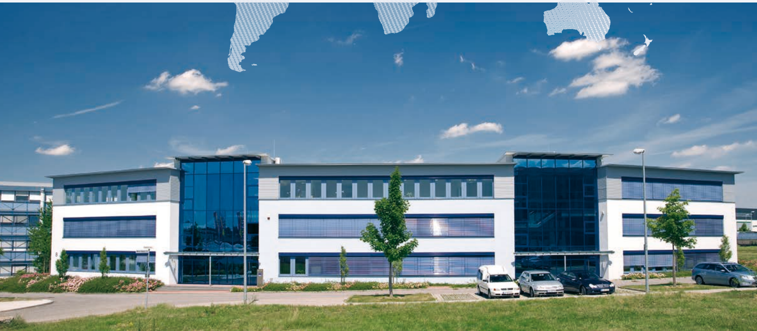
Firmengebäude Christoph Gärtner in Bietigheim-Bissingen / Our premises in Bietigheim-Bissingen, Germany
